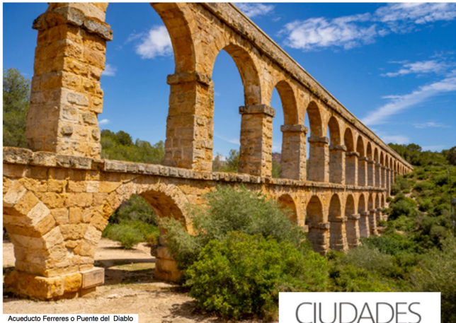
Acueducto Ferreres o Puente del Diablo
